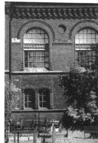
Landsarkivet i Lund. Detalj av magasinets fasad. (Foto av författaren 1997.)
