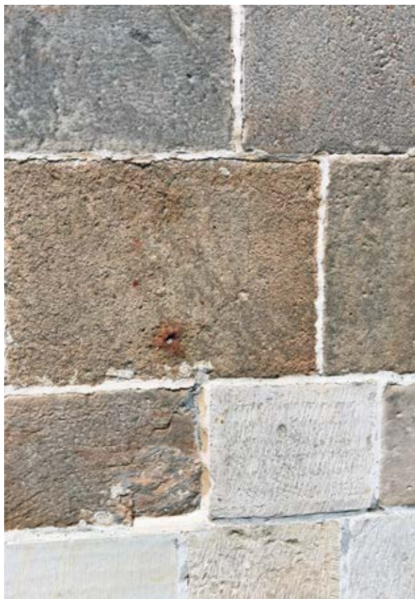
Fig. 1. Bilden visar Höörsandsten i Vä kyrkas fasad och den stora skillnaden mellan den grusiga Kvarnstenen och den ljusa homogena Lundastenen/Skellingstenen. Den nyhuggna Lundastenen kommer med tiden att mörkna. Foto: Anders Ödman.
