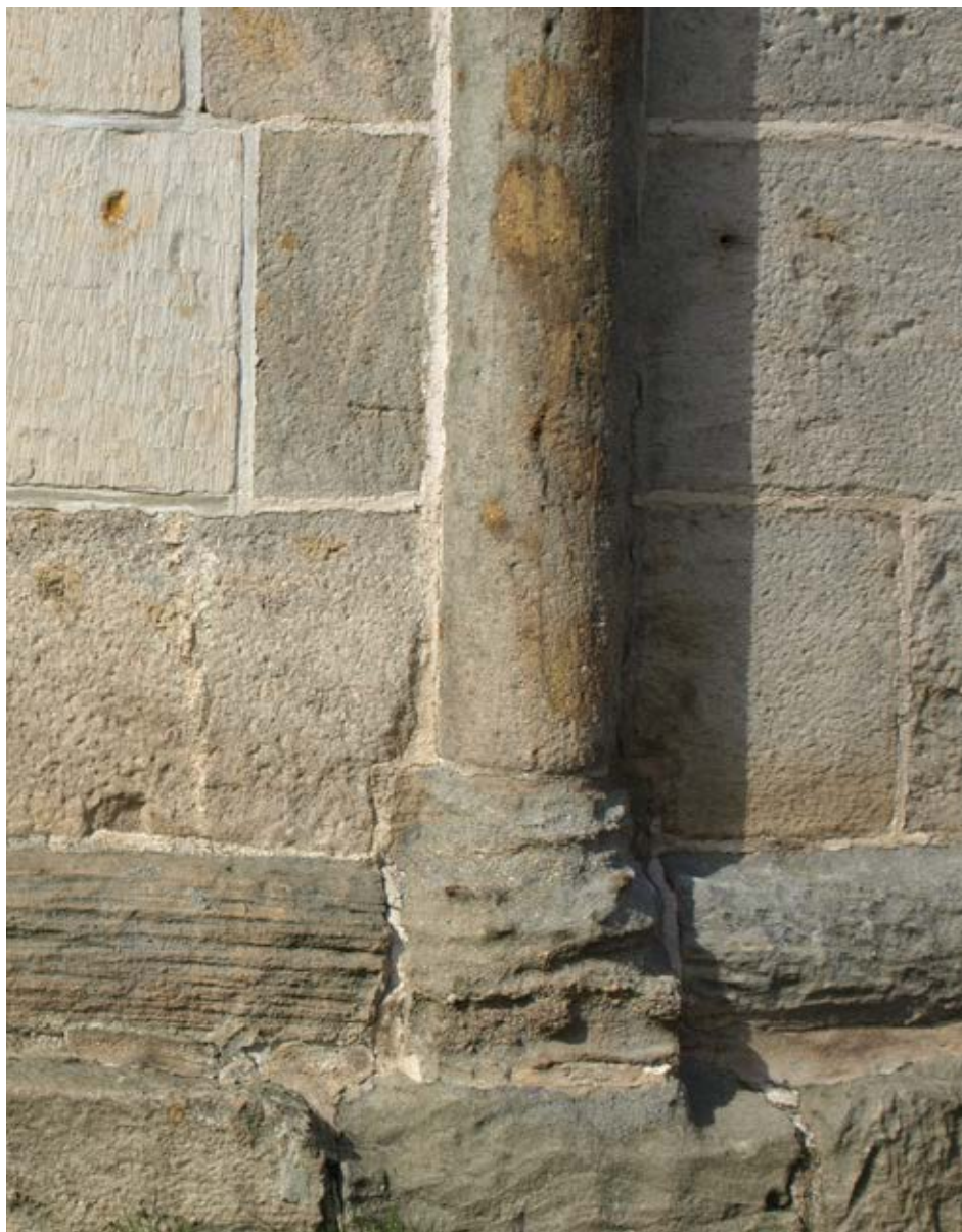
Fig. 10. Vittringsskador på korets östra sida. Till vänster syns Lundasten som i sen tid har ersatt vittrad Kvarnsten. Foto: Anders Ödman.
