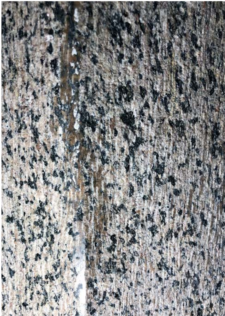
Fig. 17. Närbild av graniten/syeniten med den omsorgsfulla horisontalbehuggningen. Den brandskadade ytan har huggits bort. Troligen med bredmejsel. En liten polerad yta syns på bilden. Foto: Anders Ödman.
