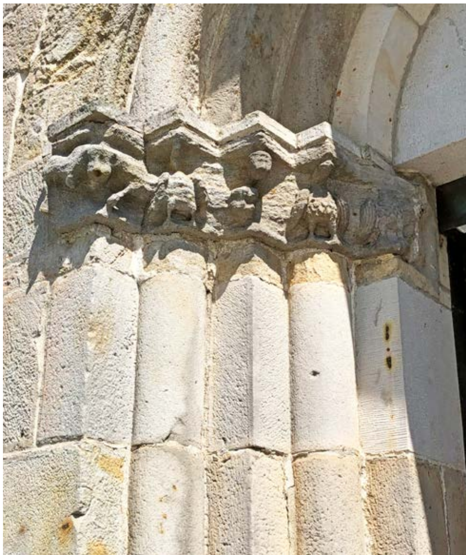
Fig. 11. Västportalens ursprungliga kapitälband är hugget i en mycket lerhaltig sandstenskvalitet. Foto: Anders Ödman.
