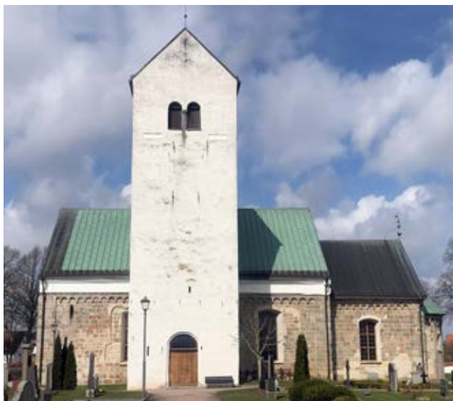
Fig. 22. Den vita tegelmurningen över den egentliga takfoten är betingad av att kyrkans välvning tog hänsyn till emporkapellets öppningar mot långhuset. Se nästa bild. Foto: Anders Ödman.
