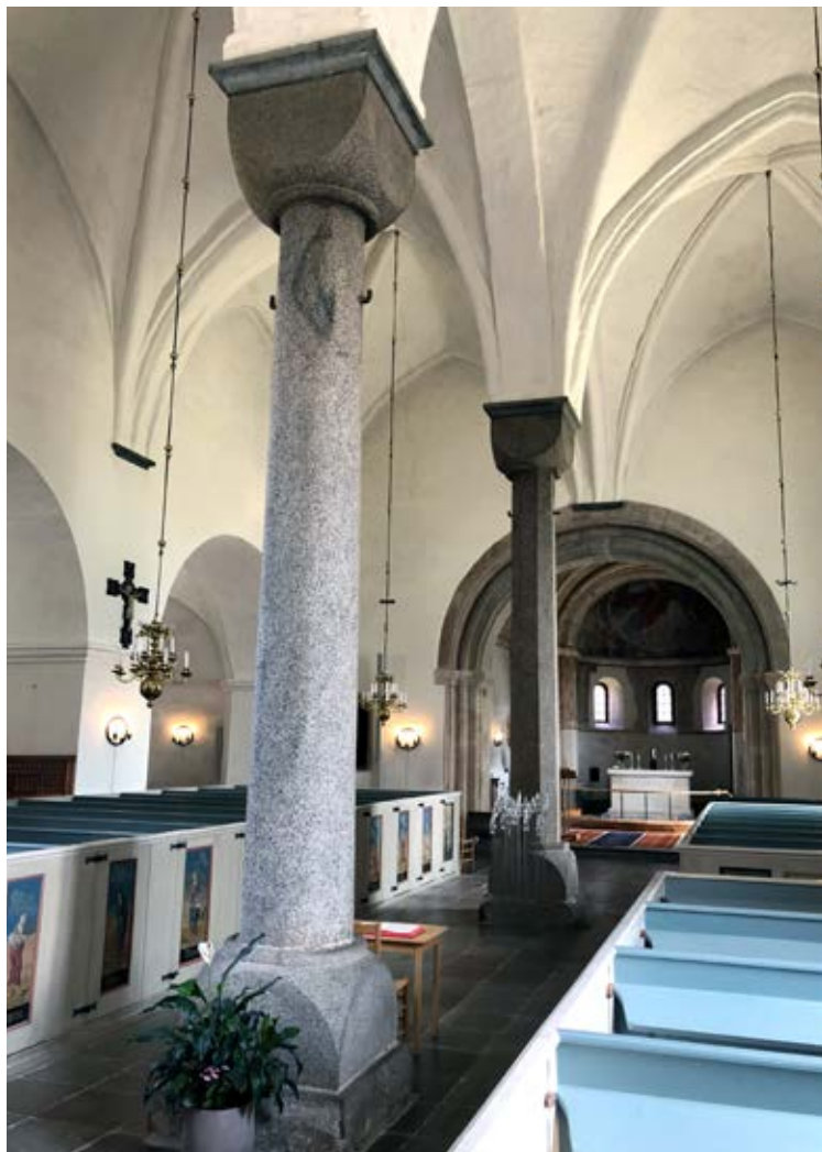
Fig. 16. De två kolonnerna i kyrkans långhus med koret i bakgrunden. Den borte kolonnen är åttkantig och den hitre är rund. Båda är omsorgsfullt behuggna, men har ursprungligen varit polerade. Foto: Anders Ödman.
