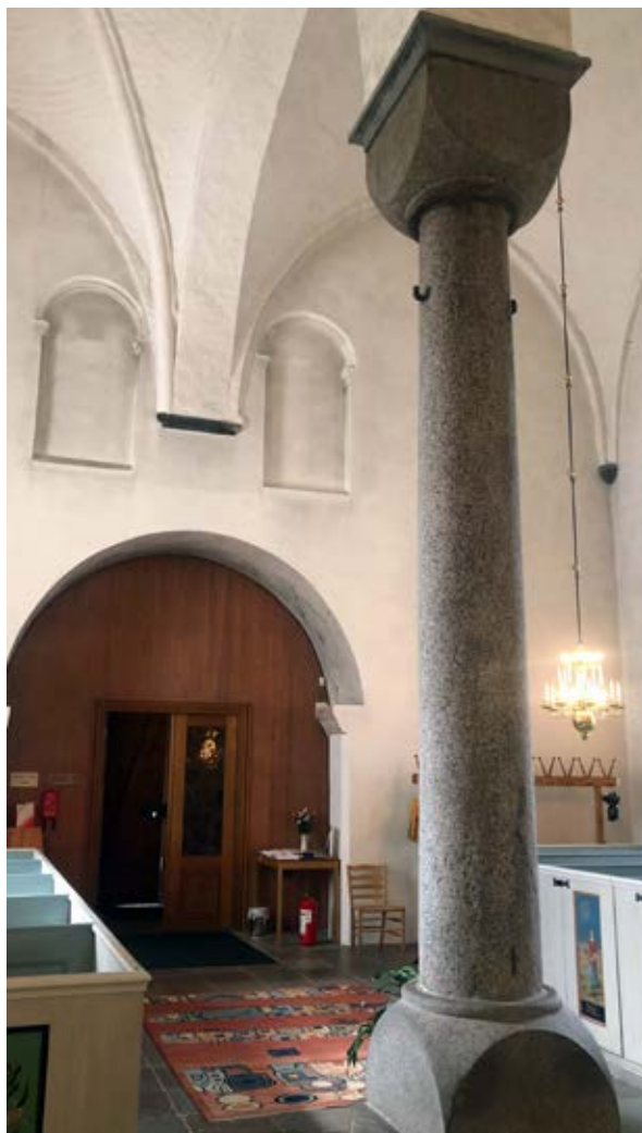
Fig. 23. Långhusvalvets sköldbågar i väster har byggts med hänsyn till emporkapellets öppningar mot långhuset Foto: Anders Ödman.
