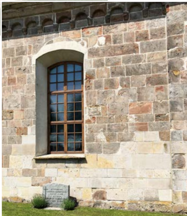
Fig. 14 a-b. Ovan syns de skador som långhus/tornväggen fick vid branden 1213 och på bilden till höger syns skadorna på korväggen. Detta verkar ha varit de punkter där de träbyggda klosterlängorna slutit an mot stenkyrkan Foto: Anders Ödman.
