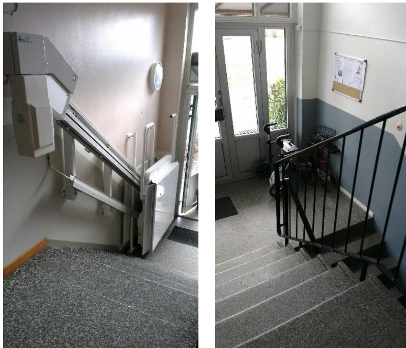
Figur 10. Plattformshiss och parkerad rollator på Frälsegårdsvägen 23.
