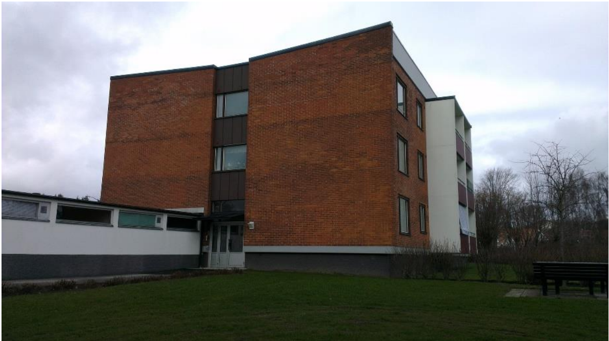
Figur 12. Befintlig entré till Frälsegårdsvägen 23.
