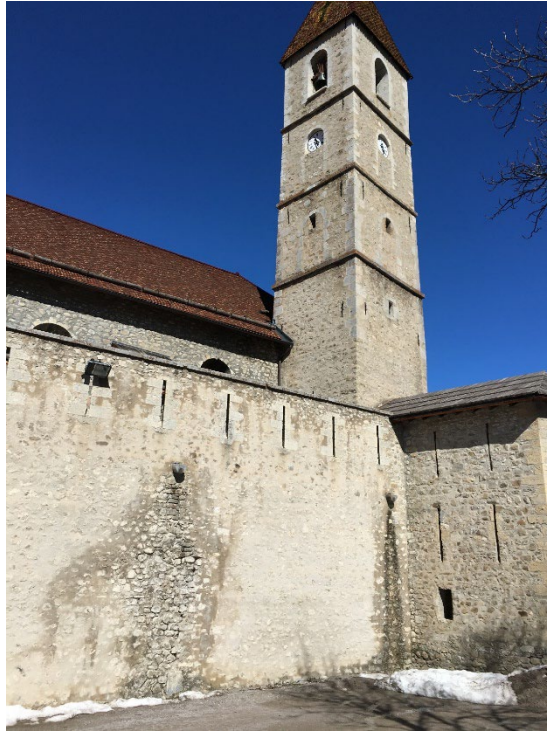
Figur 2: Exempel på hur kalkbruk löses upp då det ständigt utsätts för rinnande vatten: Bakom skottgluggarna i murens övre del finns en gångbrygga. Denna avvattnas via öppningar i murverket. Vattnet som rinner ut löser kalkbruket. (Colmars, Frankrike)
