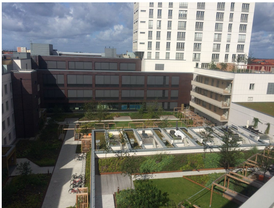
Figur 3.4 Exempel på olika slags solavskärmning. Den bruna fasaden är försedd med utvändig mörk screenväv som är nerfälld i bilden. Till höger i bild finns balkonger/loftgångar som skuggar fönstren. Det vita uppstickande huset är försett med mellanglaspersienner, och man kan tydligt se vilka fönster som har dem nerfällda. (Foto: Helena Bülow-Hübe)
