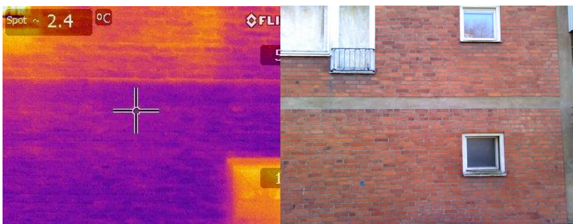
Figur 21: Termografering av betongband i fasad.
