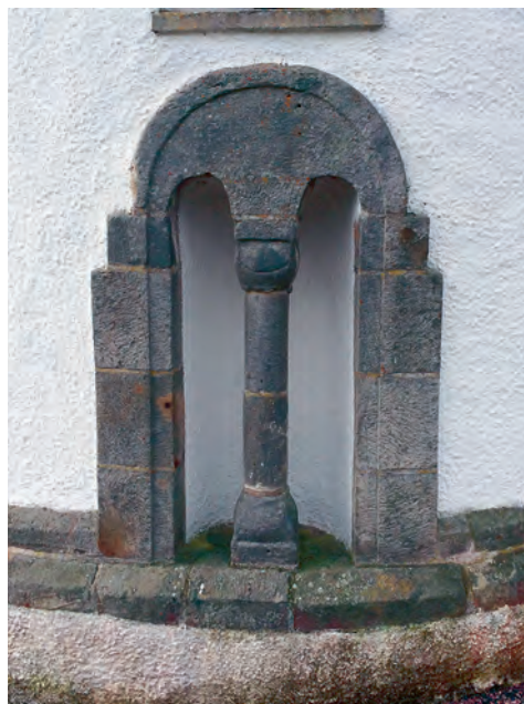
Figur 10. Fulltofta kyrkas absid är dekorerad med en kolonn i en nisch. Bas och kapitäl är av den sfäriska form som också finns i Gudmuntorp. Foto: Chatarina Ödman.
