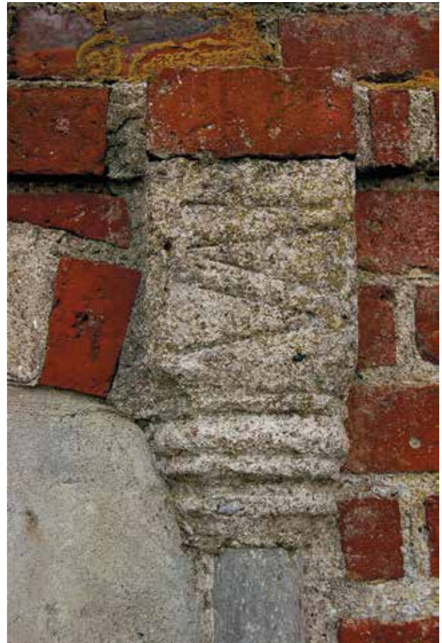
Figur 7. Detalj från översta tinnen med den ursprungliga vapenskölden till vänster och den med cement modulerade skölden till höger. Foto Anders Reinsnert, 2014.
