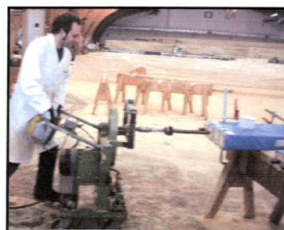
Figur 8. Applicering av gängade stänger.
