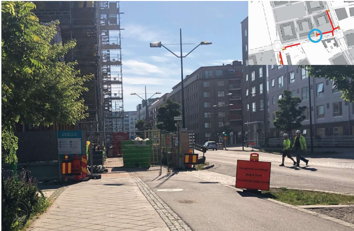
Figur 15. Avstängning och omledning som cyklister som cyklar österut möter vid byggarbetsplatsen.
