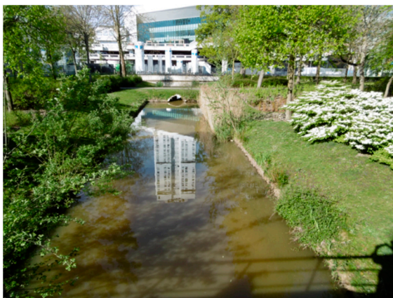
Bild 15. Bild på infiltrations- och vattenuppsamlingsyta i Rotterdam (foto: Michael Johansson)
