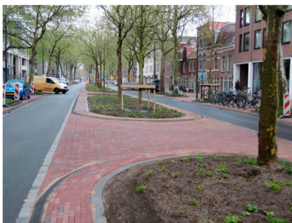
Bild 4. Bilden är hämtad från Leiden i Nederländerna och visar exempel på restaurering av en kombination av regnplantering och trädallé (foto: Michael Johansson)
