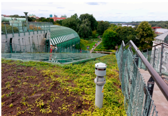
Bild 5. Universitetsbiblioteket i Warszawa sett från taket (Foto: Jan Henrik Nilsson)
