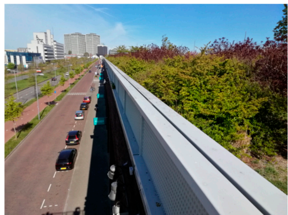
Bild 6. Dakpark i Rotterdam (foto: Michael Johansson)
