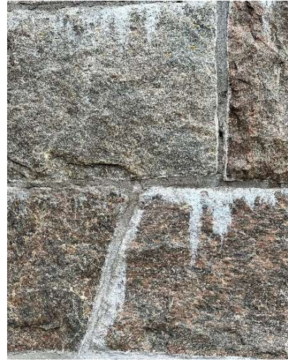
Fogbruk 8, september 2023. Delvis vittrad. Detta bruk härdade långsamt, vilket noterades vid studieresa i september 2022.
