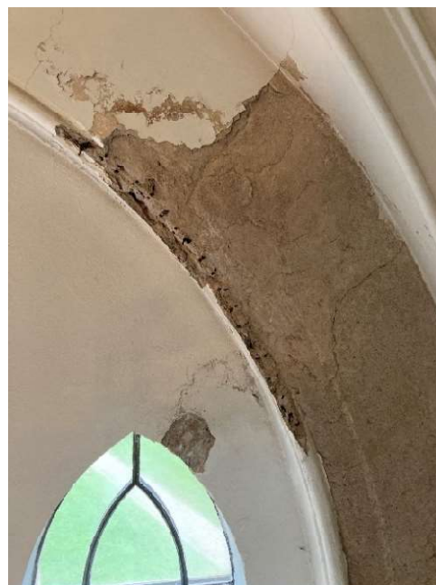
Figur 3.2 Invändiga saltrelaterade beständighetsproblem i Alfshögs kyrka.
