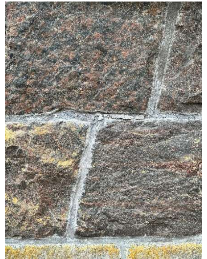
Fogbruk 9, juli 2023. Delvis vittrad. Detta bruk härdade långsamt, vilket noterades vid studieresa i september 2022.
