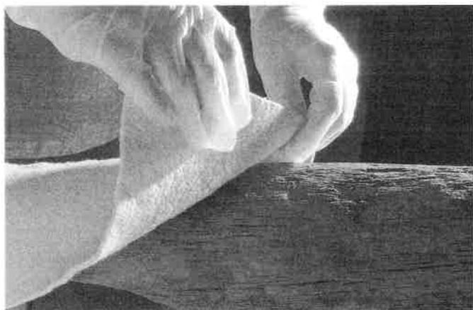
図14●アルカリ溶液を浸した湿布で酸性部分を処理することにより、木材の劣化を一時的に防ぐことができる。
