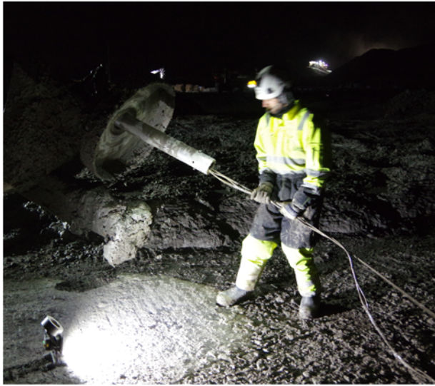
Figur 32 Elektrodkabeln förs in i borrhållningen på KC-riggen och avslutas med FOPS-vinge som förankring i botten av KC-pelaren i Bålsta (Foto: Torleif Dahlin).
