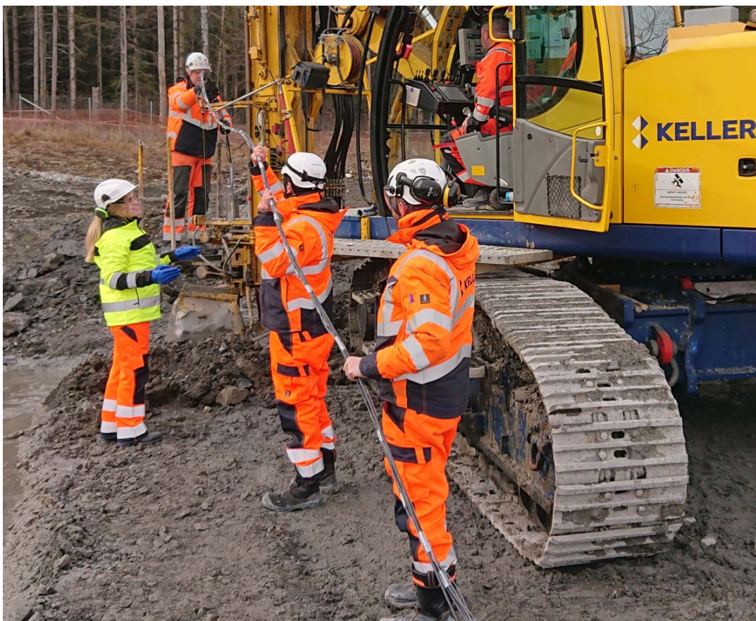
Figur 37. Fältförsök med installation av elektroder och temperaturgivare i jetpelare i Moss (Foto: Torleif Dahlin).
