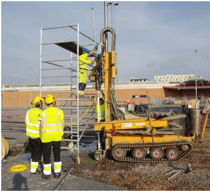
Figur 25. Fälttester med ERT i Göteborg, sommaren 2018. Här gjordes mätningarna med ERT-kablar för borrhålsmätning som fördes ner i slitsade grundvattenrör (Foto: Torleif Dahlin).
