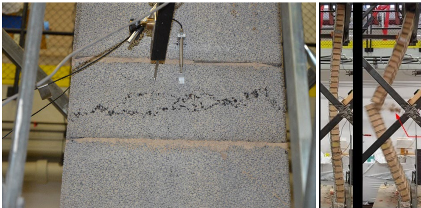
Bild 3.1 Lokalt böjtryckbrott i lättklinkervägg (vänster); tegelvägg som knäcks och är på väg att kollapsa (höger). Källa: Molnár med flera 2021.
