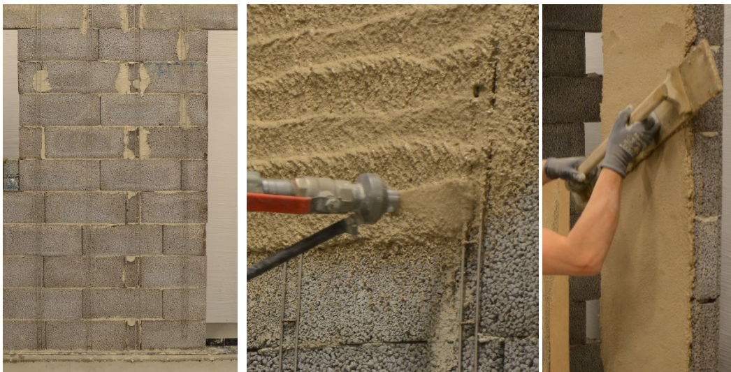
Bild 2.2 Ytförstärkning av vägg. Fixering av bistålet (vänster); sprutning av förstärkningsputsens (mitt); avjämning av förstärkningsputsens.
