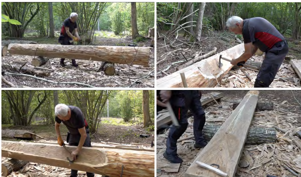
Bild 19–22. Rekonstruktion av en väggstav så som i Hemse stavkyrka uttagen i par från en ekstam. Arbetet utfördes huvudsakligen med rekonstruerade verktyg från fyndet av en verktygslåda i den från Hemse närbelägna Mästermyr (Almevik, Pärnsten & Sjöholm 2020; 2021). Observera den alternativa tolkningen av stavplankans nederdel.
