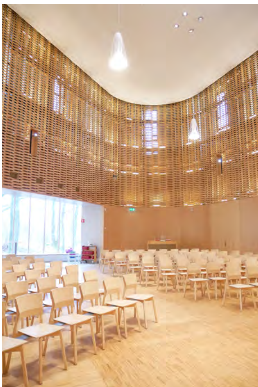
Foto 3. Livereds kapell, nederst på väggarna träpanel, därover korgvävda väggar av plywoodlatter.
