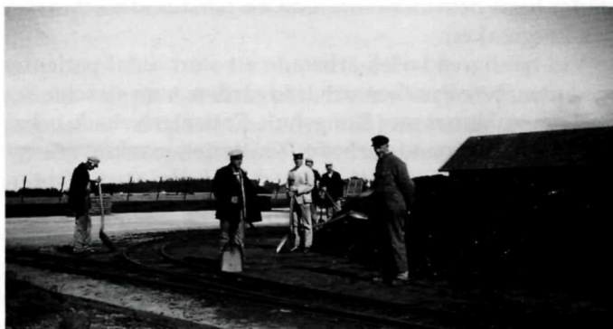
Kolskyffling 1928. I det dagliga utarbetet ingick för några patienter att köra kol till värmecentralen. Varje dag skyfflades kol upp i vagnar som på räls kördes ned till maskinrummet. Foto Olle Olsson.
