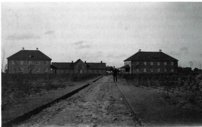
Vy mot öppendörrpaviljongerna 8 och 10 (numera 39 och 40), troligen 1927. I fonden syns måleri- och snickeriverkstanen. Bakom denna låg det nu rivna bårhuset med obduktionssal. Foto Medicinhistoriska museet.
