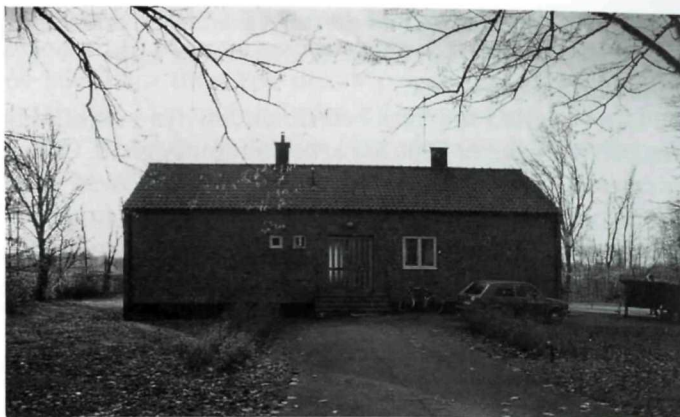
Andreläkarvillan byggdes 1951. På samma sätt som Carl Westman hade låtit överläkarvillan präglas av monumental avskildhet, gav Hakon Ahlberg andreläkarvillan en form av raffinemang och villaliknande exklusivitet som placerar den litet vid sidan av den övriga arkitekturen på sjukhusområdet. Foto Ulf Celander.
