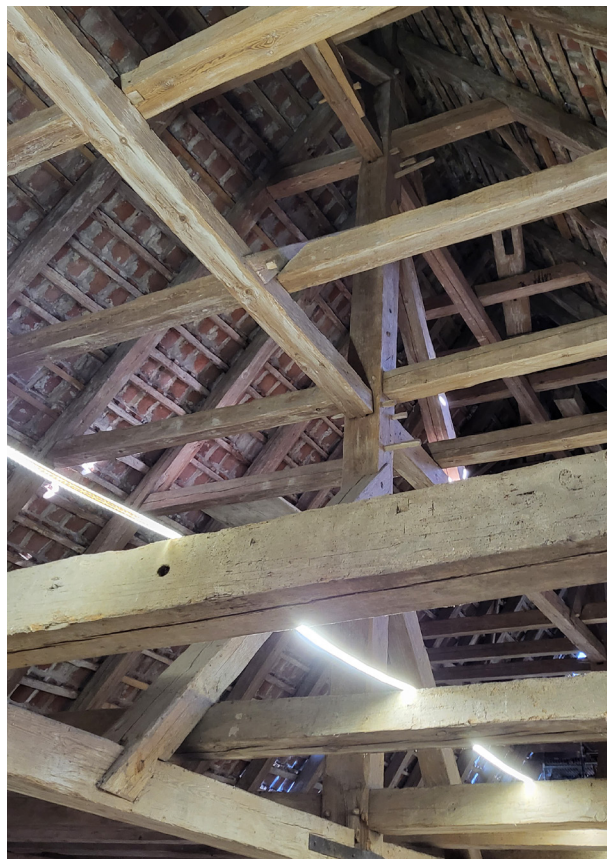
Fig. 13 Takstolen på Glimmingehus. Mitt i bilden syns en av de fem s.k. kungarna. Det ljusa strecket är en ljusslinga, utlagd för byggarbeten. Foto: Sara Williamsson, 2022.
