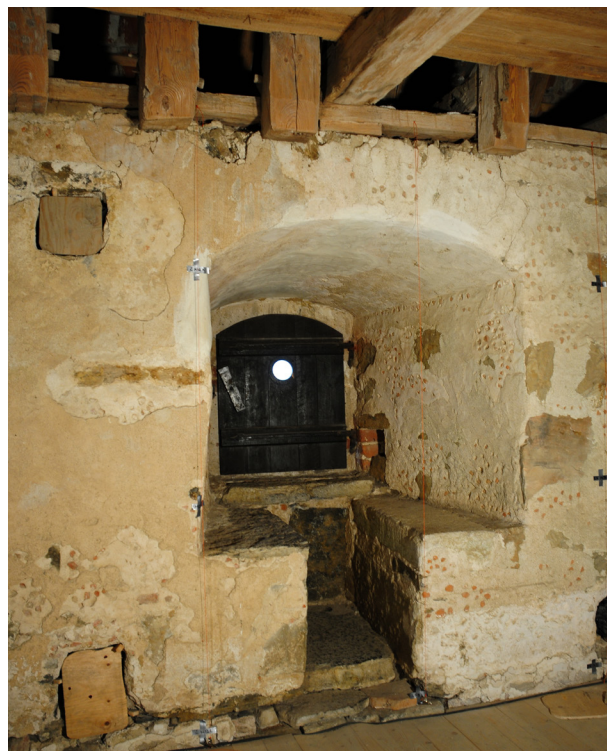
Fig. 14 Fönsternisch (kontext 216). Notera sittbänkar av Komstadkalksten och gotländska kalksten, samt Komstadkalkstenen i golv samt väggbeklädnad. På murkrönet ser man de avfasade bockbenen. Foto: Tina Westergren, 2011.
