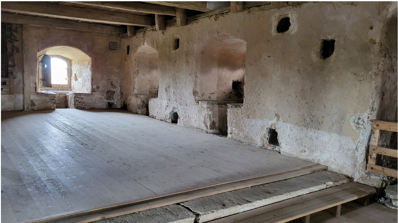
Fig. 12 Rum 2 fotograferat från sydost. Notera nivåskillnaden i golvet, samt de avfasade bockbenen som slutar nedanför murkrönet. På fotot syns också några av de genomgående, fyrkantiga hålen. Foto: Sara Williamsson, 2024.
