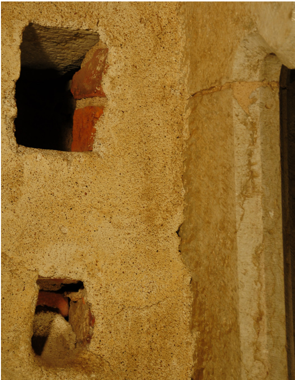
Fig. 9 De två igenmurade röckkanalerna, norr om spisen. Ritning 1Ö2. Foto: Tina Westergren, 2011.
