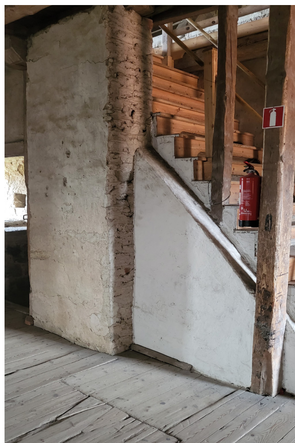
Fig. 11 Trappan fotograferad från NV. Notera fyrkanten i trägolvet, där skorstenen gått upp, samt avtrycken efter skorstenens tegel på väggpartiets norra sida. Murpartiet under trappan tillkom på 1900-talet. Foto: Sara Williamsson, 2024.
