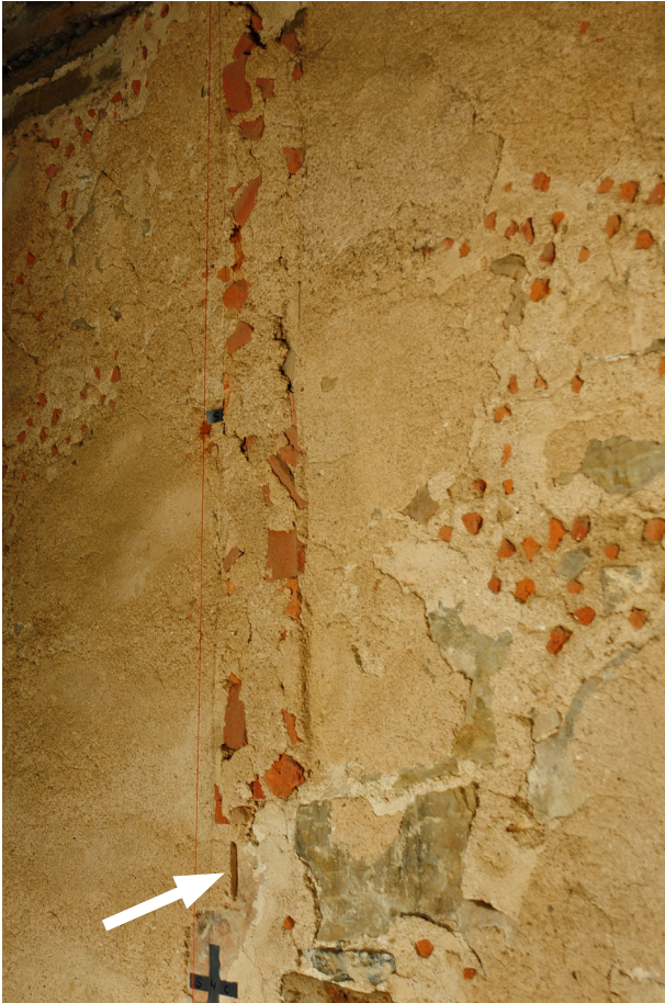
Fig. 8 ett utjämningskift (kontext 136) på södra väggen, rum 1. Notera att det saknas puts under utjämningskiftet. Pilen markerar en tydlig kant i putsen där den tidigare legat an mot utjämningskiftet. Ritning 1S2. Foto: Tina Westergren, 2011.
