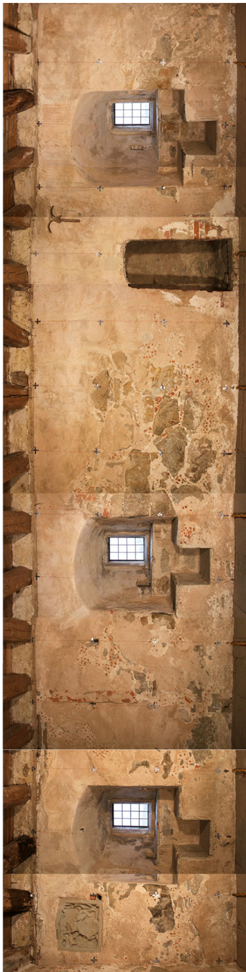
Fig. 4 Ett exempel på hur fotounderlaget för ritningarna rektifierats och monterats ihop. Rum 1, södra väggen. Notera att fokus legat på att göra väggytorna så korrekta som möjligt, med följd att tak och golv stundtals skevar. Foto: Tina Westergren, 2011.
