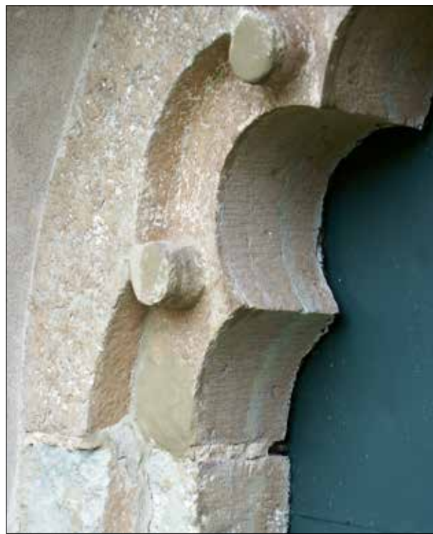
Fig. 11a–b. Flistads kyrka, Östergötland, portal i norr, indirekt dendrodatering ca 1320. Observera den spetsbågiga portalomfattningen och behugning med tandad mejsel. Foto: Göran Tagesson.
