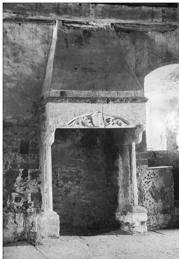
Fig. 4. Spisen i Riddarsalen. Notera den oputsade väggen till vänster om spisen, där rökkanaler visar att en extern, sekundär eldplats varit uppbyggd. Området putsades över senast 1940. Foto: S. Brandell, okänt årtal.
