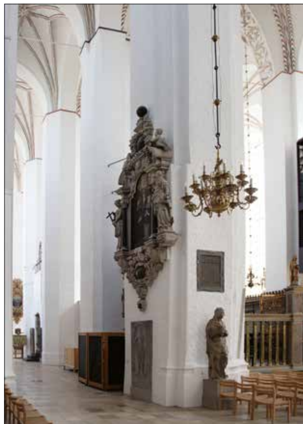
Fig. 4. Det senmiddelalderlige hallekors nordre pillerække set mod sydøst. Mens de to østre pillepar er opført fra grunden over oktogonale planer, er det vestre pillepars ottekantede form frembragt ved behugning af ældre piller med retkantede hjørner. Foto: Thomas Bertelsen 2024.
