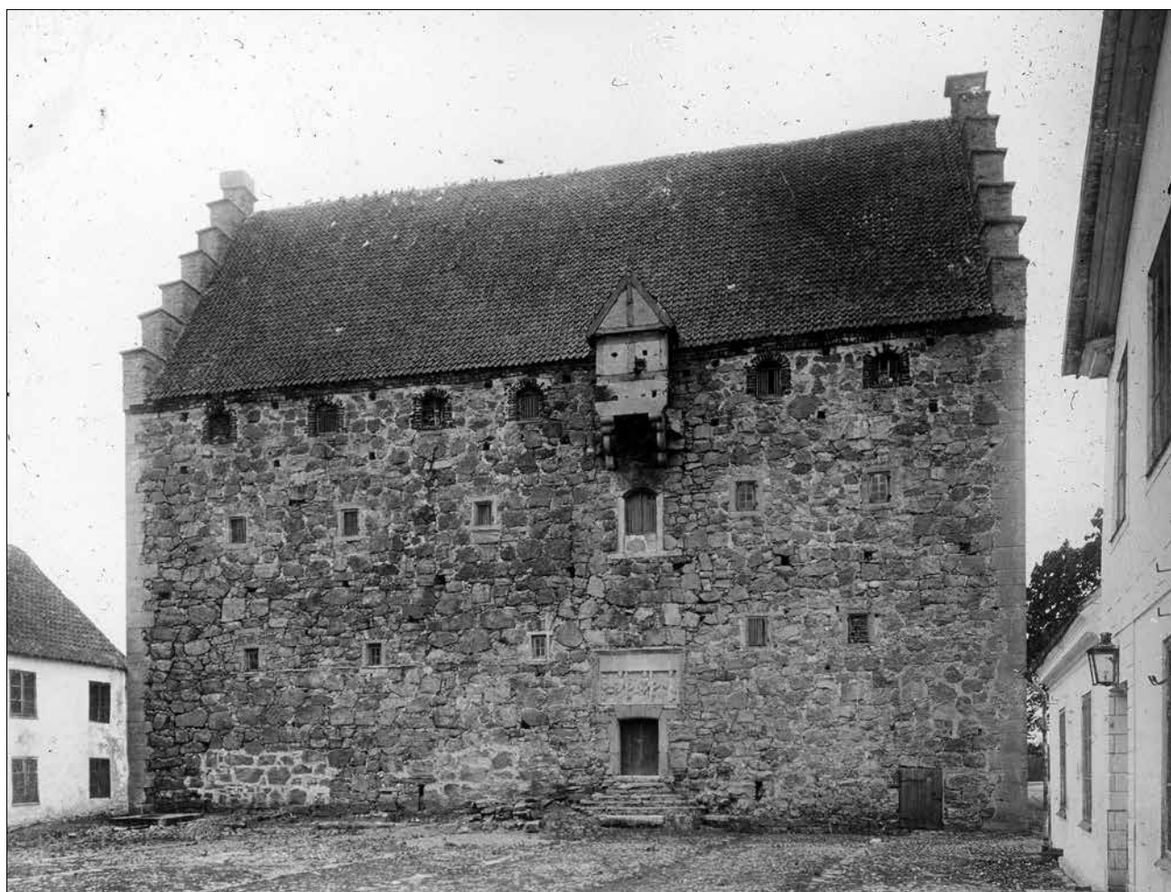
Fig. 2. Norra fasaden före restaureringarna. Notera de igenmurade fönsteröppningarna och den sekundära dörröppningen till höger. Den östra längan har ännu ingen dörröppning i södra delen av fasaden. Publicerad 1909 i Svenska slott och herresäten vid 1900-talets början , Skåne. Foto: P. Bagge. Public domain.
