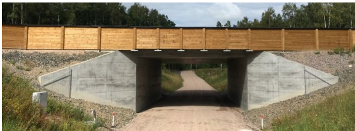
Figur C.1. Foto av plattrambro konstruerad och byggd 2020.
