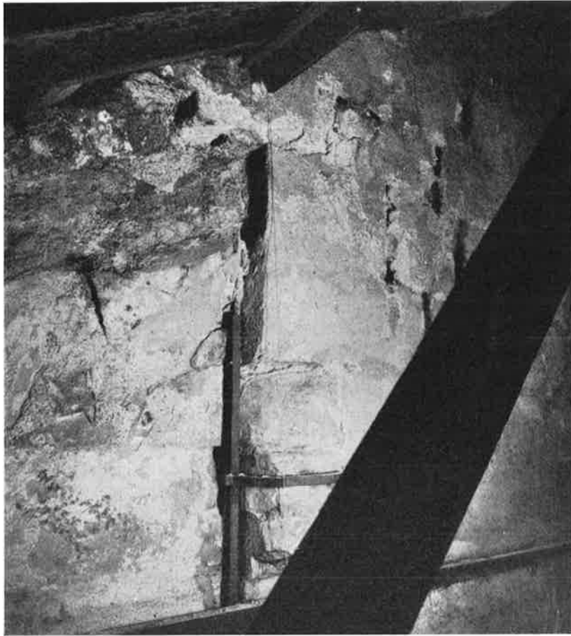
Fig. 6. Fogen mellan den äldre muren och dess stödmur.
