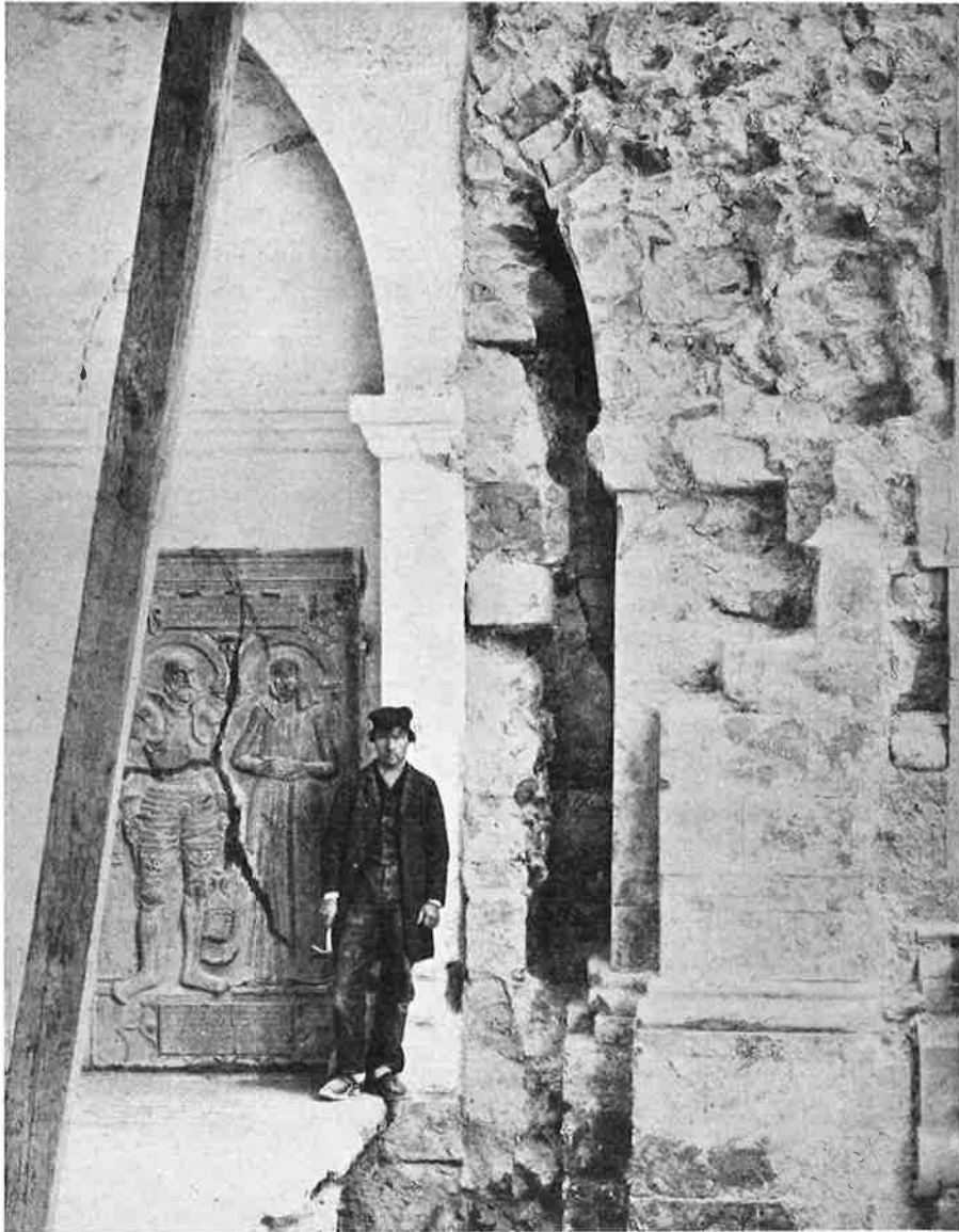
Fig. 38. Rester efter den äldsta förhallen blottade vid rivningen av tornen. (Efter Rydbeck 1923.)
