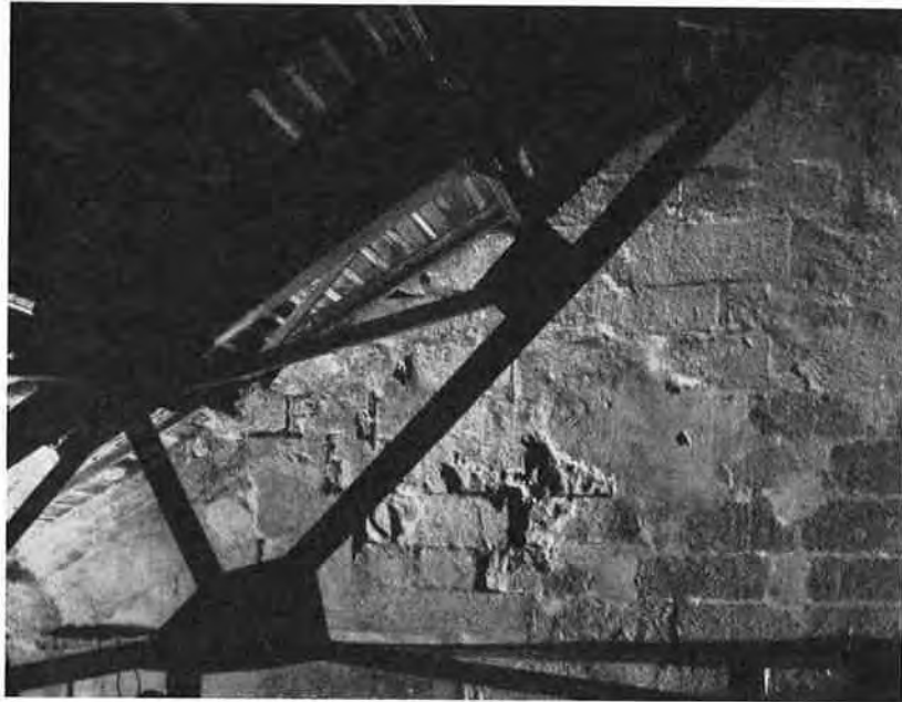
Fig. 4. Äldre murparti i norra sidoskeppsvindens östra vägg.
