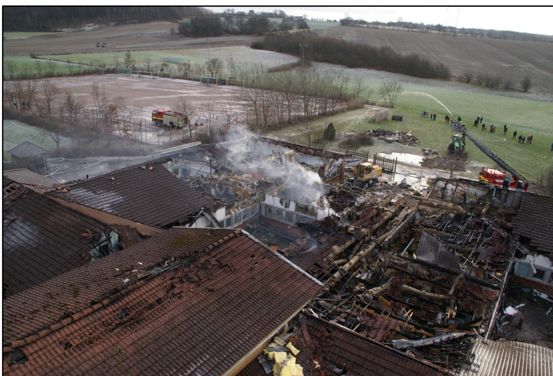
Figur 19; Så kallade konstruktionsbränder kan få en annan karaktäristik än rumsbränder, vilket kan kräva ett annat synsätt på släckning.
