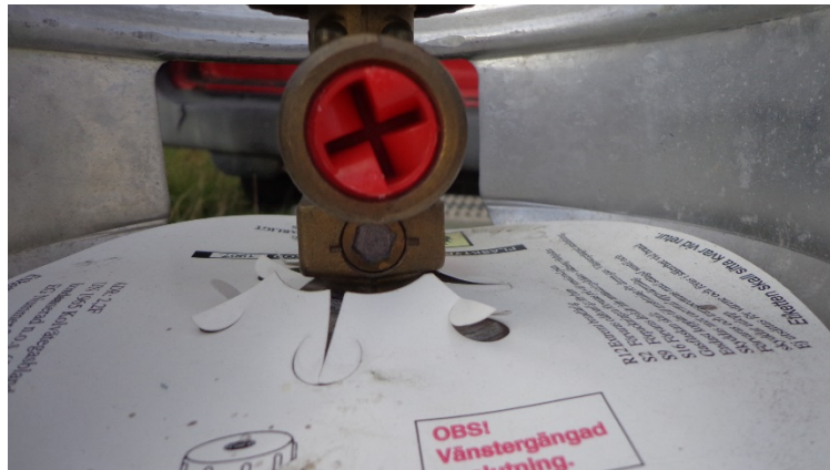
Figur 38. Gasanslutning med röd plugg samt smältsäkring under denna.
