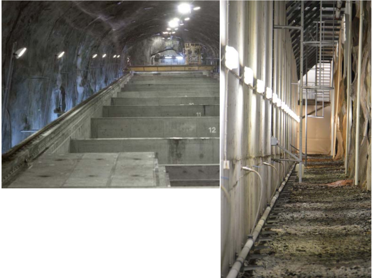
Bild 1. Bergrummet IBMA med dess betongkonstruktion (tv) och mellanrummet mellan betongkonstruktionen och berget (th) som kommer att fyllas med makadam. Foto SKB.
