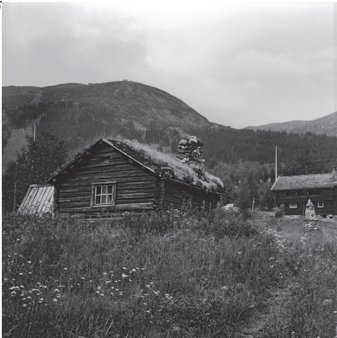
Fig. 3 Costruzione tradizionale con tetto in torba nella valle di Åre, 1955.
