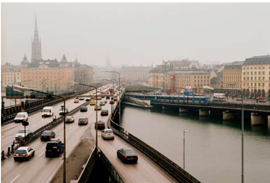
Saltsjö-Mälarsnittet i centrala Stockholm, först byggt för fotgängare och handel via bl.a. båttransporter, i mitten av 1900-talet kompletterat (bypass-opererat?) med pulsådor för andra trafikslag.
