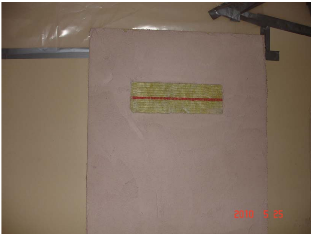
FOTO 4. Färdig vägg med urgröpning i putsen innan baljan monteras.
