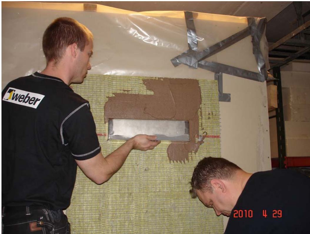
FOTO 3. Grundningen påbörjas. Baljan hålls på plats för att markera området som inte ska putsas.
