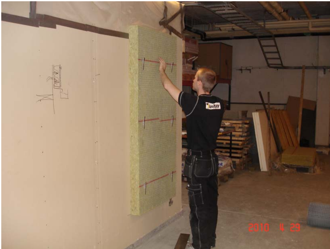
FOTO 1. Stenullsskivan är monterad på gipsskivan.
