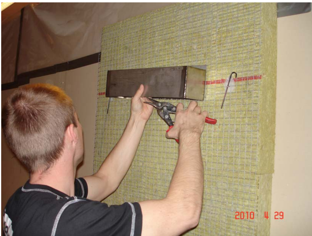
FOTO 2. Stålåtsarmeringen klipps bort där baljan ska monteras.
