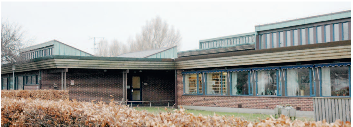
Figur 3: Kullagymnasiets västra fasader på byggnaderna E och F med takkupor. Andra våningen på byggnad A syns i bakgrunden.
