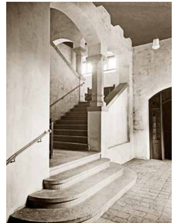
Trapphuset. Foto: Theodor Wählin.
