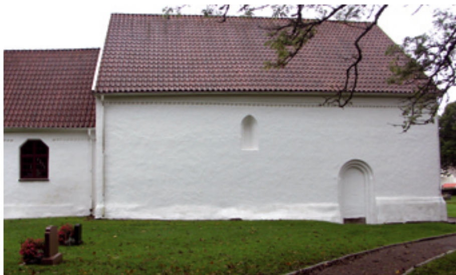
Fig. 9:13. Tegelkyrkan i Torpa. Den tvåsprångiga nordportalen murades igen år 1804. 36 På långhusets mitt syns en igensatt senromansk fönsteröppning. Kyrkan har sockel och en fris under takfoten (Foto: förf., okt. 2006).
