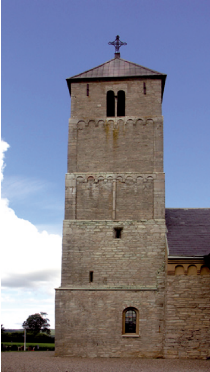
Fig. 4:9. Romanska västtorn uppvisar en stor formmässig variation. Västtornet i Heda i Östergötland är exempelvis dekorerat med rundbågsfriser och lisener, och har i likhet med flera andra västtorn i Östergötland och Närke en gradvis avtrappning uppåt. Den nuvarande tornhuvén är sekundär; den ursprungliga huvén var av sten (Bonnier 2004a:41ff. Foto: förf., aug. 2007).
