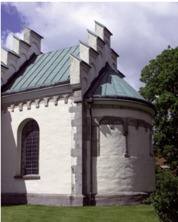
Fig. 4:26. Korpartiet i Höörs kyrka i Skåne. Koret har under takfoten en enkel rundbågefris, medan absiden artikuleras med en blindarkad med tärningskapitäl-försedda halvkolonneter med snodda skaft (Foto: förf., juni 2005).
