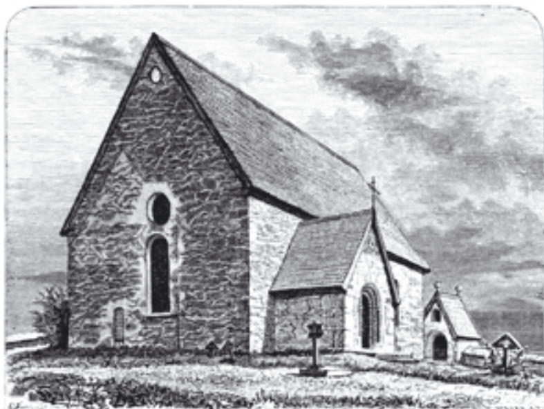
Fig. 5:1. Från början var Trönö gamla kyrka i Hälsingland en liten romansk kyrka med smalare kor, men i början av 1500-talet utvidgades anläggningen till en betydligt större salkyrka. I det oputsade murverket kan spår av det ursprungliga långhuset urskiljas i västgaveln (Bonnier 1995:108ff, Nisbeth 2008, bild efter Hildebrand 1898-1903).
