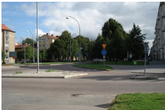
Typ 6, cykelpassage i korsningen Norra Kungsgatan/ Hälsingegatan i Gävle. Bild: Jutta Pauna (2008).
