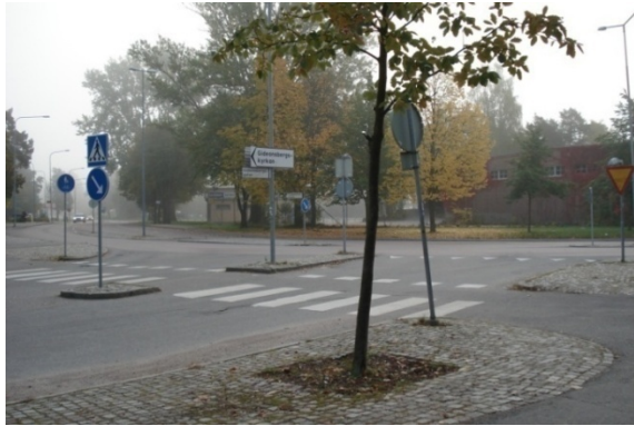
Typ 2, cykelöverfart i korsningen Gideonsbergsgatan/ Långmårtensgatan i Västerås. Bild: Jutta Pauna (2008).
