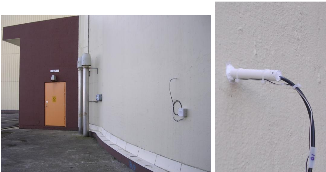
Figur 5.3.3. Placering av mätpunkt i förhållande till intagsslussen, nivå +104 (vänster bild). RF-sensor monterad i plaströr samt termoelement mellan plaströr och betong för temperaturmätning av betongen (höger bild).
