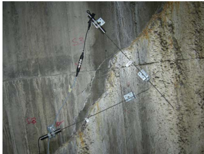
Figur 6.5 Mätning av sprickrörelser i Storfinnforsens damm år 2006 och pågående med LVDT-givare K3 och K8.
