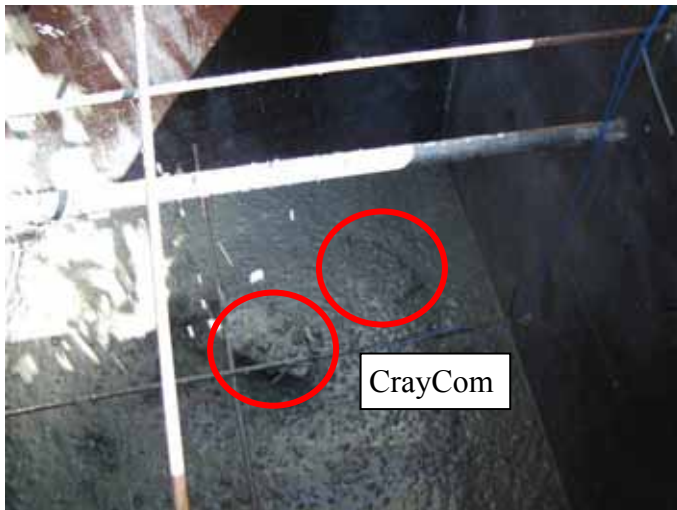
Figur 33. Ingjutning av mätutrustningen.
