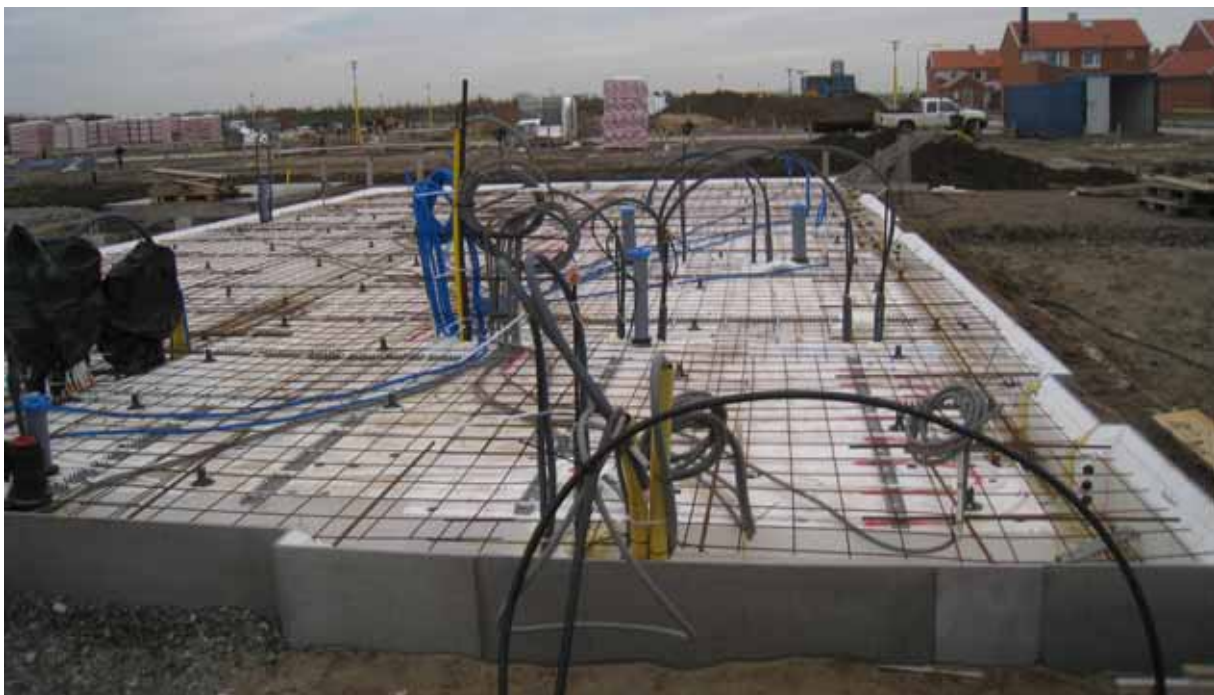
Figur 2. Armerad bottenplatta och kantavstyvning (vot) till enfamiljshus.
