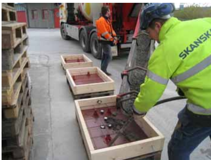
Figur 10. Gjutning med betongrännor samt vibratorstav
