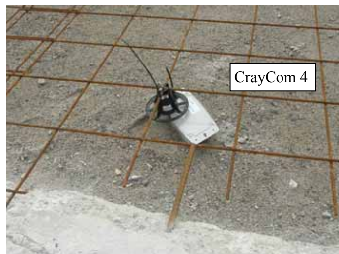
Figur 41. Placering av CrayCom 4 under "tassen"..
