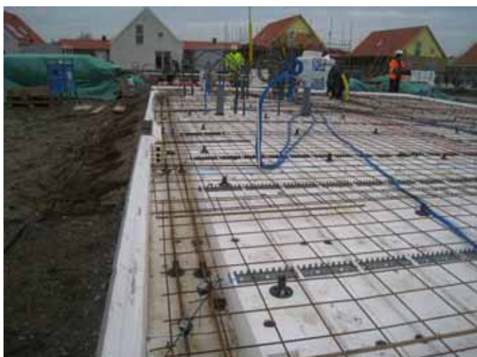
Figur 21. Kantförstyvning med samtliga noder
