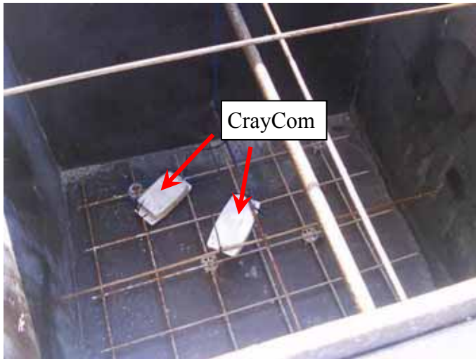
Figur 31. Placering av CrayCom på armeringsjärn.
