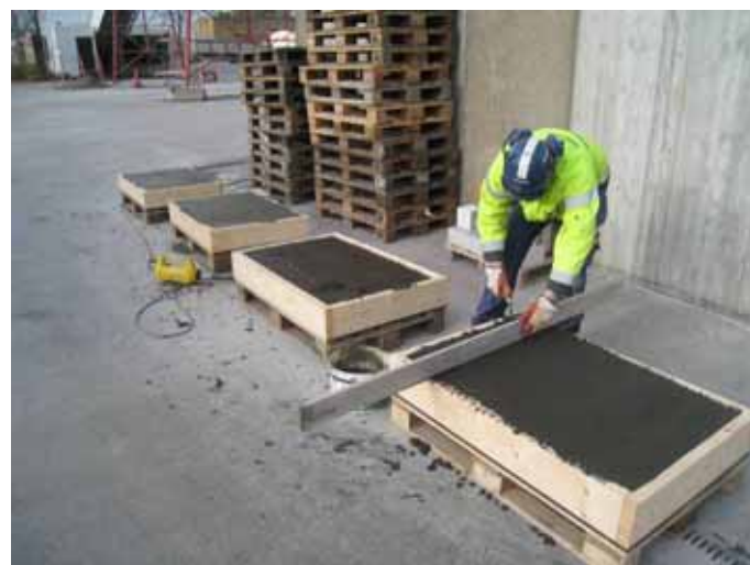
Figur 11. Avdrag därefter täckning och brädrivning av yta
