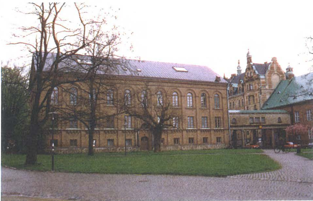
Museibygnaden vid Krafts torg med övergången till Domkyrkomuseet.
