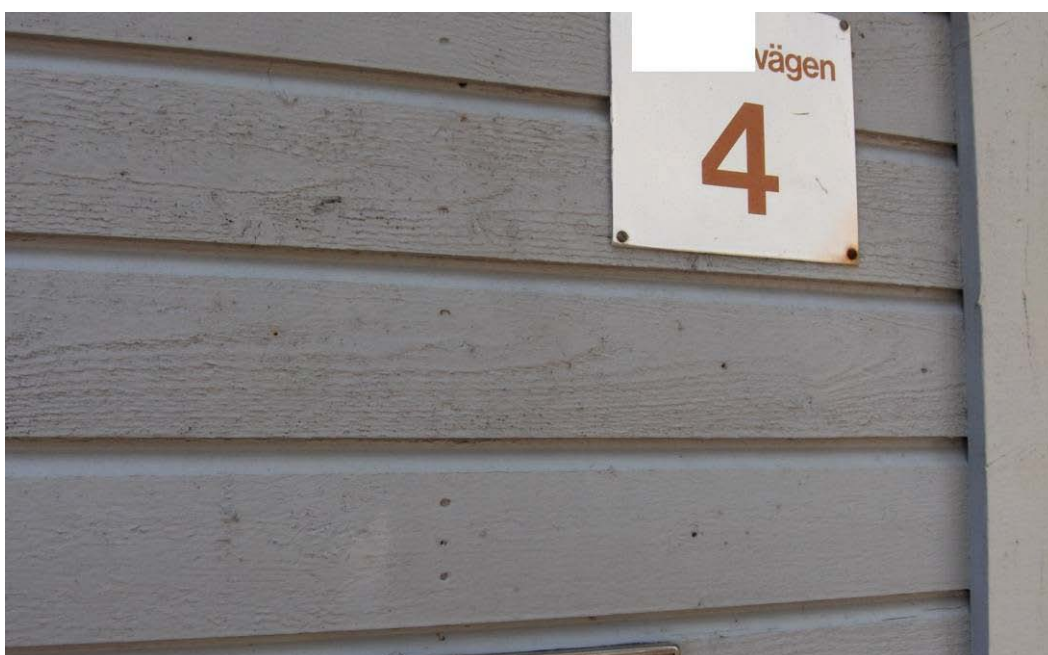
Figur 22 Liknande vertikal spikrad där några spik sitter i liv med panytan, vilket förstärker intrycket av de djupa spikhålen.
