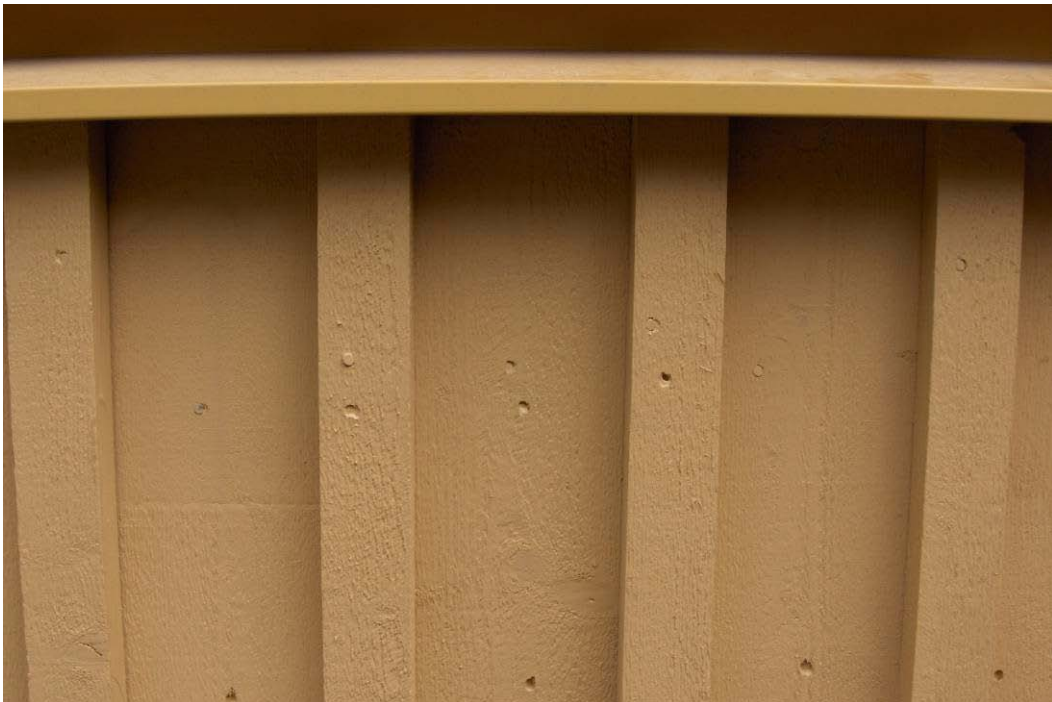
Figur 10 Spikhål som sitter ojämnt i höjdlädd och inte alltid centriskt. Några spikar är inslagna exakt i nivå med panelytan medan någon t o m inte är tillräckligt inslagen.
