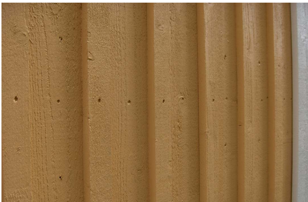
Figur 8 Närbild av fasaden i figur 7, med extra djupa spikhål.
