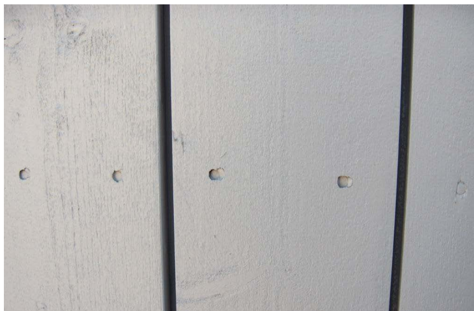
Figur 2 Andra exempel på några olika djupt inslagna spikar
