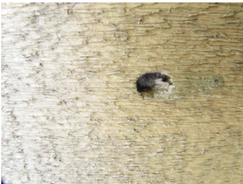
Figur 38 Mycket djupt spikhål i liggande panel.
