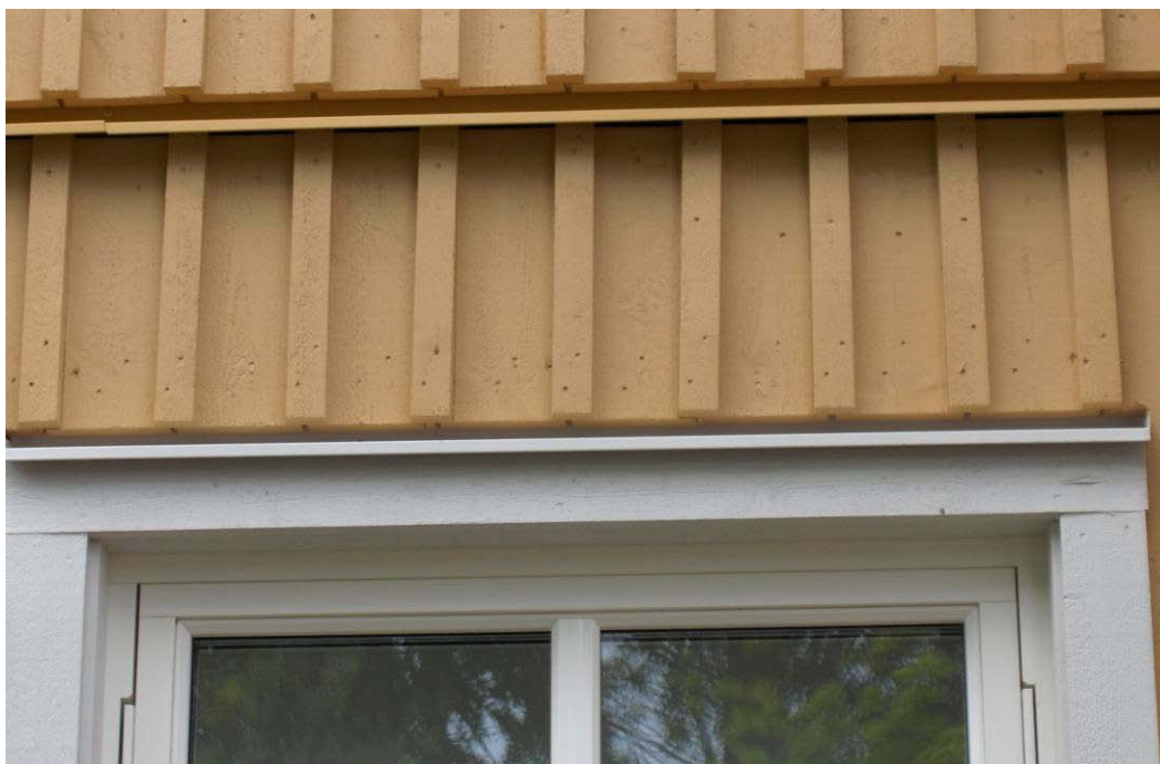
Figur 7 Stort antal, omotiverade spik som syns extremt väl p g a spikhålen.
