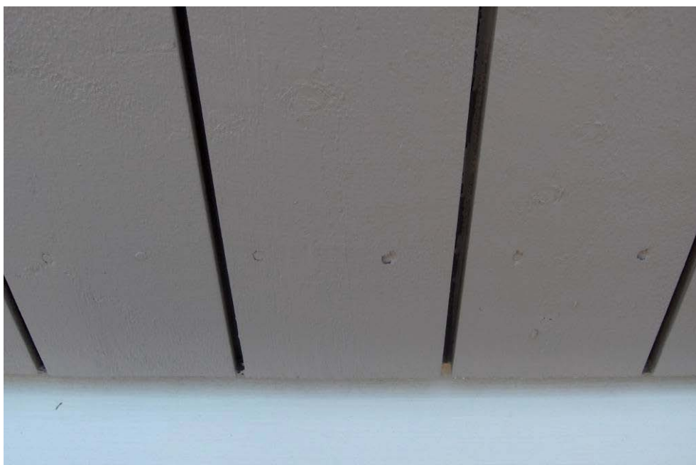
Figur 1 Stående panelbrädor utan lockbräda eller locklist. Dubbla spikar som slagits in något för djupt.
