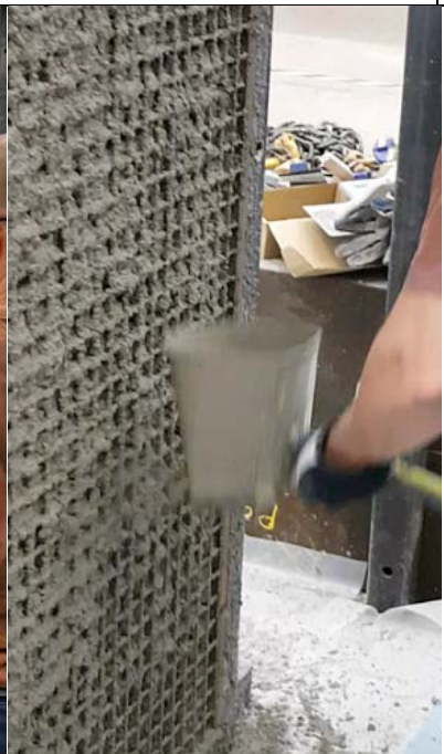
Bild 10. Andra lagret av utstockningsbruket påförs.
