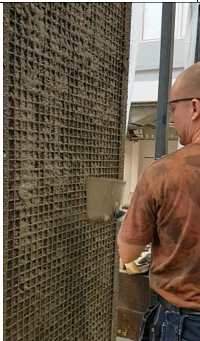
Bild 9. Första lagret av utstockningsbruket påförs.
