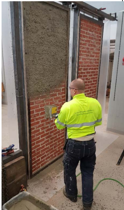
Bild 6. Grundning av testväggen.
