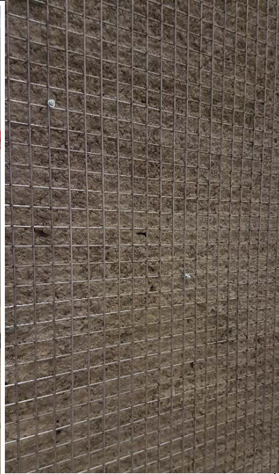
Bild 7. Nätarmeringen är monterad.
