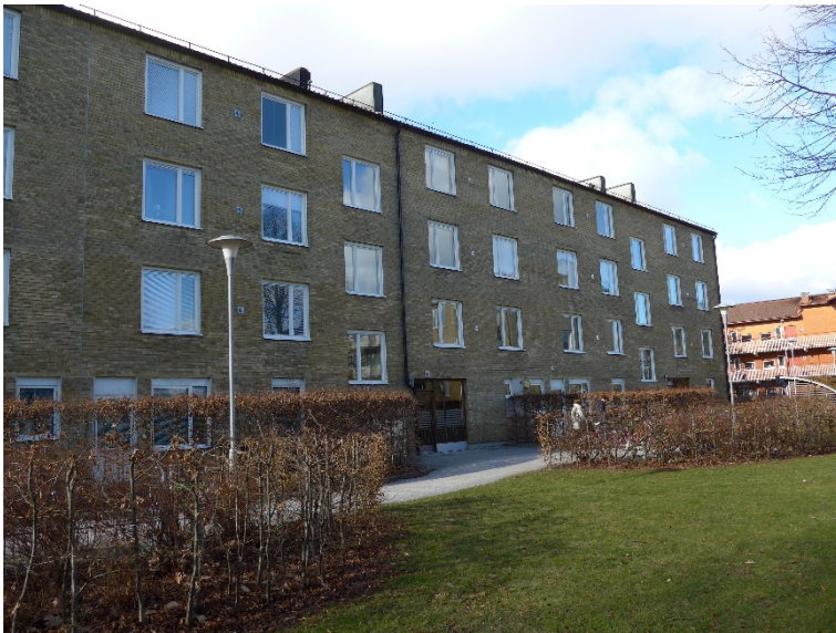
Bild 1 Flerbostadshus med fullmurade en och en halv sten tjocka ytterväggar, Lund.
