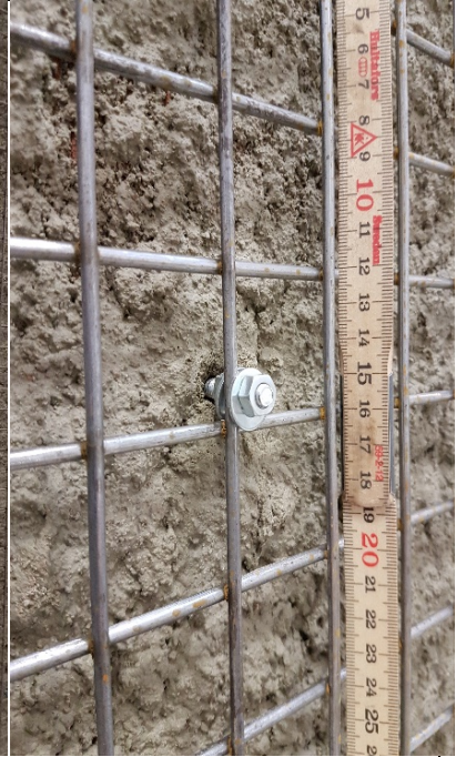
Bild 8. Närbild på nätarmeringens infästning.
