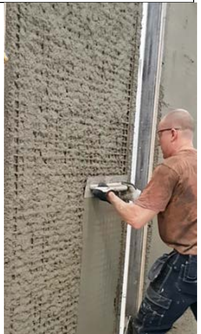
Bild 11. Komprimering av utstockningsbruket.
