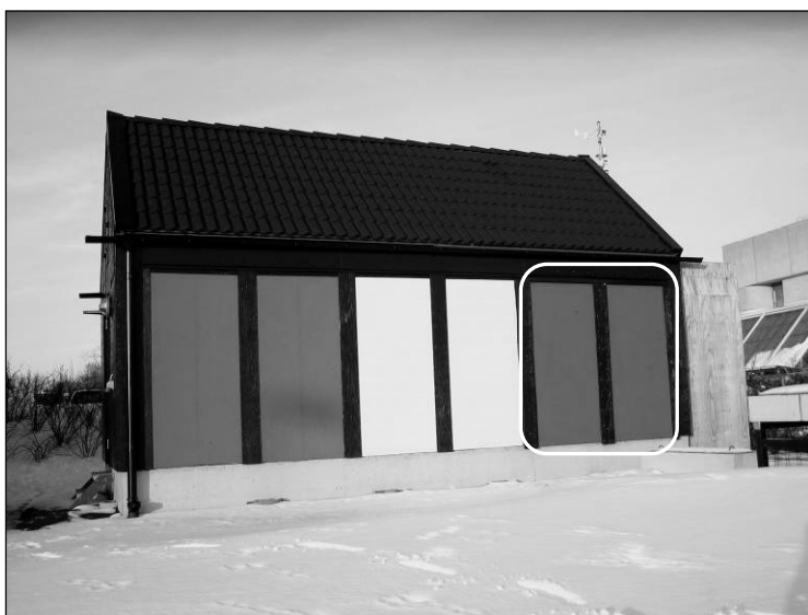
Figur 6-1 Provhusbyggnadens långfasad mot söder.
