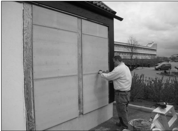
2008-04-17: Skivor Aquapanel Outdoor har monterats mot bakomliggande 25 mm tjocka träläkt. Skarv mellan skivorna cirka 3-5 mm spacklas ut med SERPO 610 Multi Flex .
