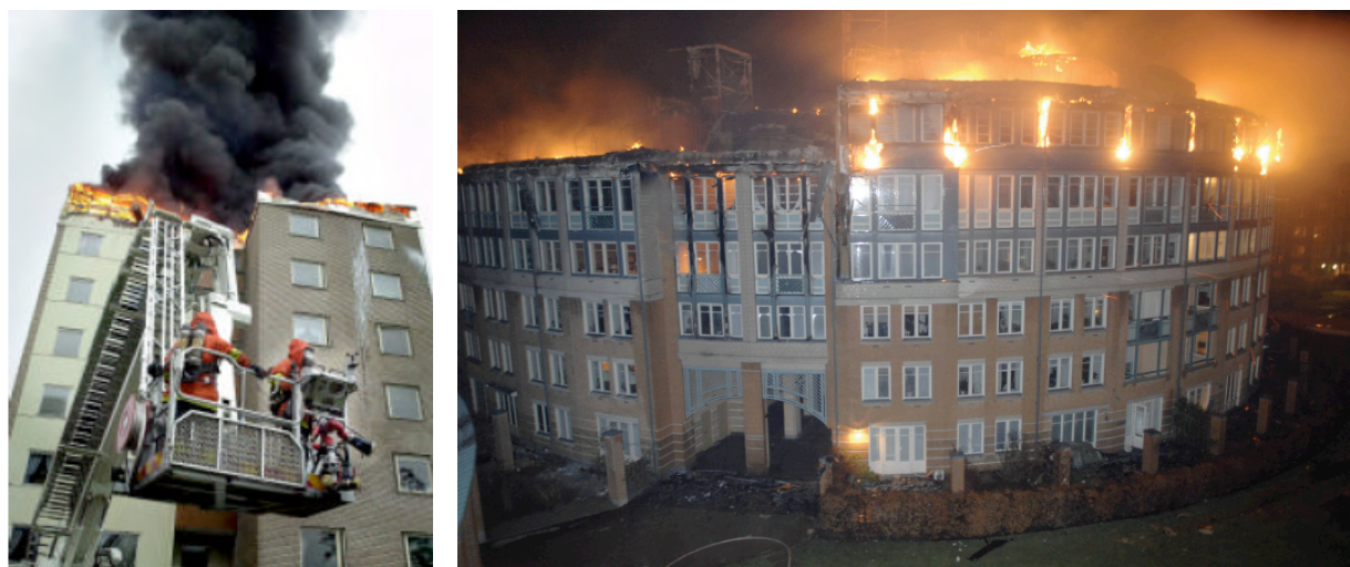
Bild 1: Två vindsbränder. T.v. en anlagd brand på vinden (hämtad från RIB med tillåtelse från Lundberg (2010)). T.h. en brand som spridits från en lägenhet till vinden (används med tillåtelse från Nilsson (2010)).
