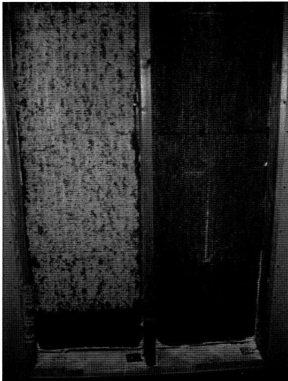
FIGUR 8a. Putsen sedd bakifrån innan vattenbegjutning påbörjas.
