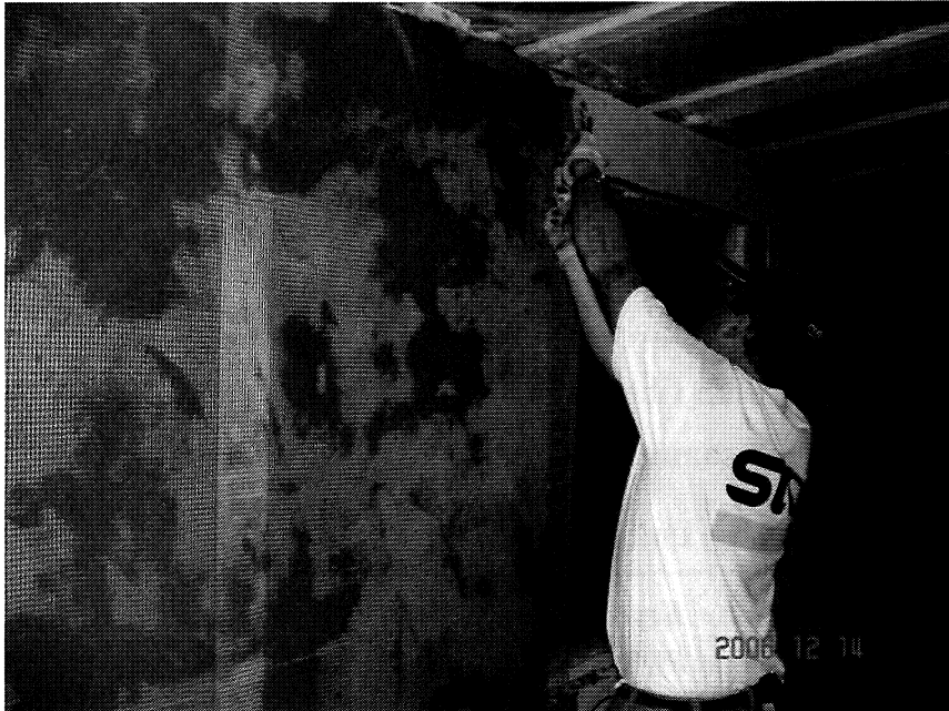
FIGUR 5. Montering av glasibernät i system 5.
