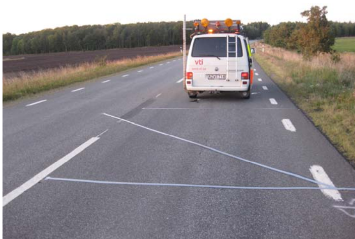
Figur 3-4 Exempel på koaxialkabelutläggning i Skåne (mätplats 1c)
