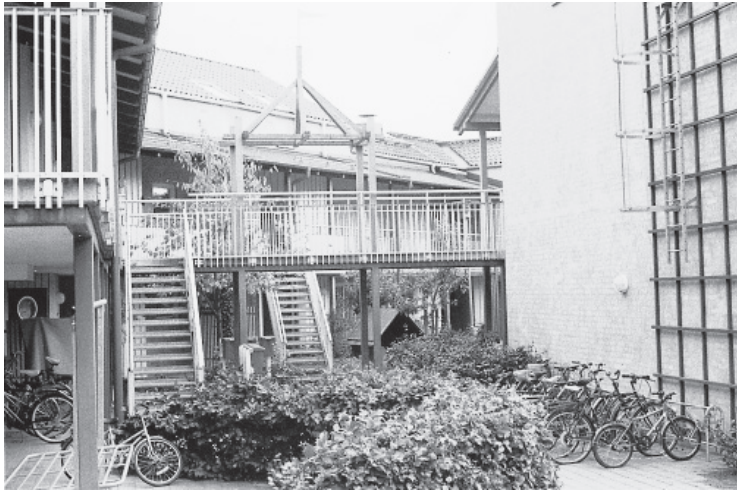
Figur 10.8 Huvudentrén till gården i Läderfabriken. Här ser man de tekniska konstruktionerna kring loftgångarna, med trappor och den brygga i luften som förbinder ovanvåningarna i de två husen. Fotot taget 981001.
