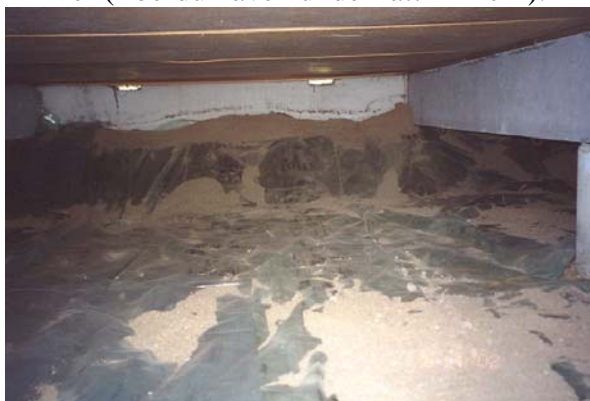
Figur 1.3 –Kryppgrund med byggplastfolie upp mot kanter med ventilationsöppningar.
