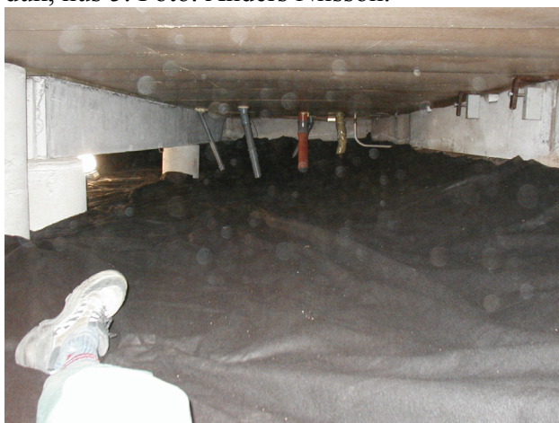
Figur 5.5 – Inblåsning av lättklinker vid mittbalk, hus 5. Foto. Anders Nilsson.
