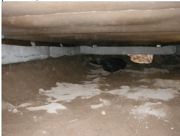
Figur 5.3 – Instiegshål till krypgrund med fiberduk, hus 5. Foto. Anders Nilsson.
