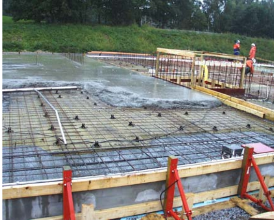
Figur 4.1 Gjutning av voter och kantförstyvningar dagen före gjutning av bottenplattan
