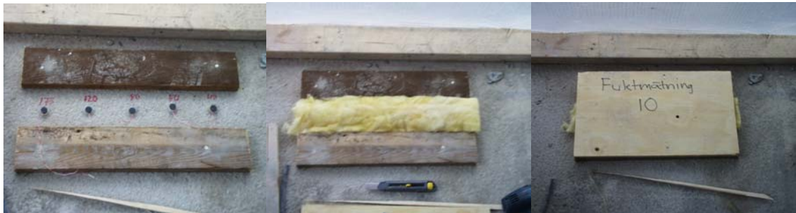
Figur 6.2 Skydd av mätpunkter under byggtiden.
