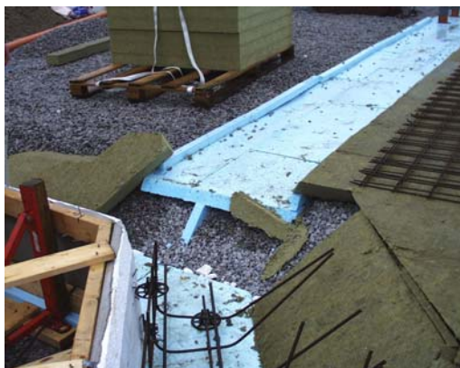
Figur 4.3 Placering av cellplast under voter för att förhindra luftläckage i sidled
