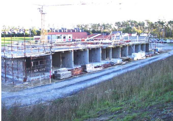
Figur 3.2 Hotelldelen under byggnation. Plattbärlaget är just monterat.
