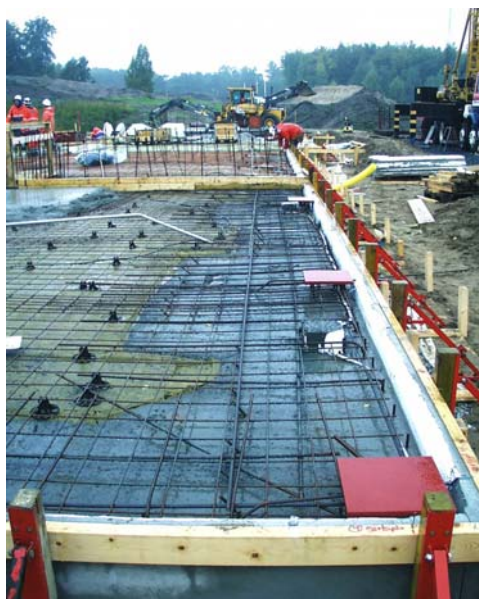
Figur 7.1 Gjutning av voter och kantförstyvningar i betong K 60
