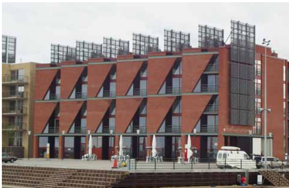
Figur 9.10 Användning av vacuumrörsolfångare, dels på fasad och dels vertikalt placerade ovanför taket som utsmyckning, på Bo01-området (Västra hamnen) i Malmö.
