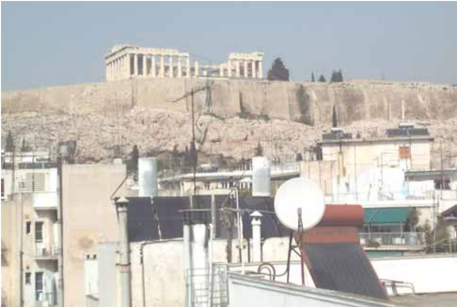
Figur 8.9 Exempel på solfångare med självcirkulerande system för tappvarmvatten på hustaken i Aten.
