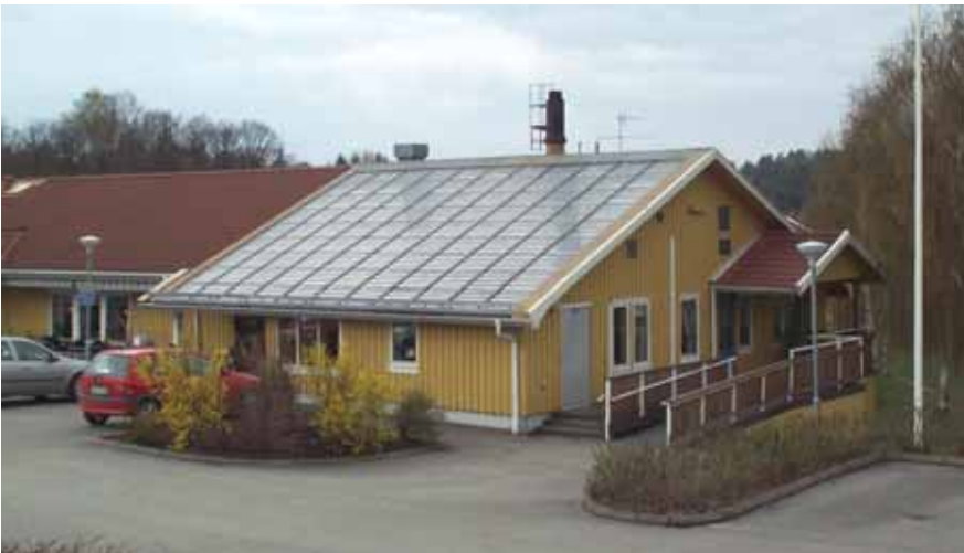
Figur 9.16 Ett av de tidigaste projekten i Sverige med takintegrerade solfångare, 80 m 2 på ett daghem i Vallda byggt 1982.
