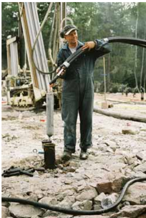
Figur 14.3 Nedsänkning av markvärmväxlare i borrhål, i detta fallet dubbla U-rör med tyngd längst ner. Foto från installationsarbetena i Annebergsprojektet med totalt 100 borrhål. Foto: Sven-Erik Lundin.
