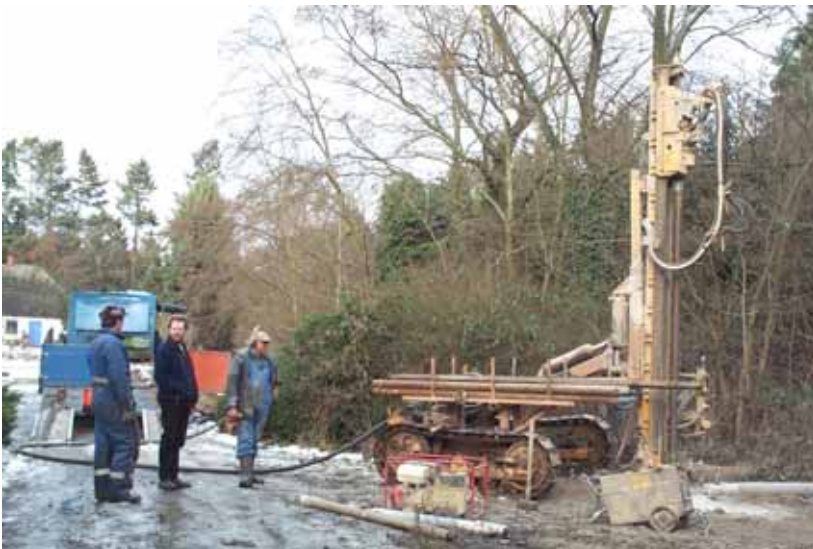
Figur 14.2 Borrning av bergvärmebrunn till villasystem.
