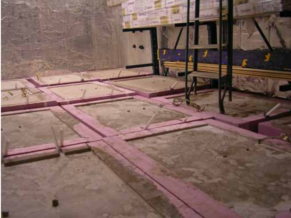
Figur 2.4.1 Provkroppar strax före avjämning. Observera att det lämnats utrymme för avjämningsmassan så att överytan av den färdiga avjämningen blir i nivå med kantisoleringen av XPS.
