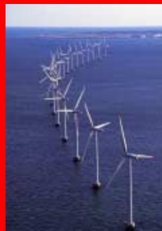
http://www.middelgrunden.dk/byggepladsen/m53.htm Systems A/S
