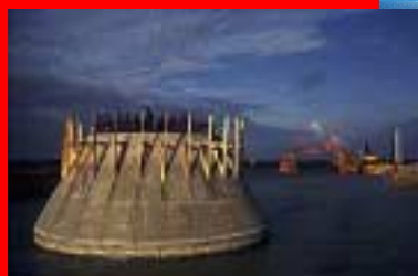
Fundamenter bliver sejlet ud til Tuno Knob Fotografi © 1996 Flemming Hagensen
