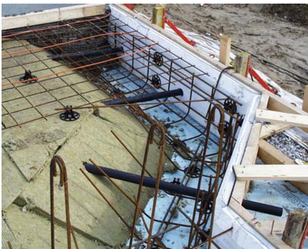
Figur 9.9 Montering av inblåsningsrör för HP-torkning.
