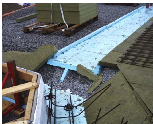
Figur 9.10 Placering av cellplast under voter för att förhindra luftläckage mellan fack.
