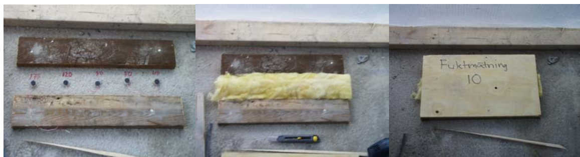
Figur 9.15 Skydd av mätpunkter under byggtiden.
