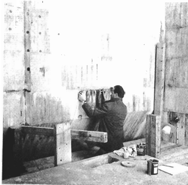
Fig 57. Storfinnforsdammen. Mätning av ljudhastighet vid gjutfog och dilatationsfog.
